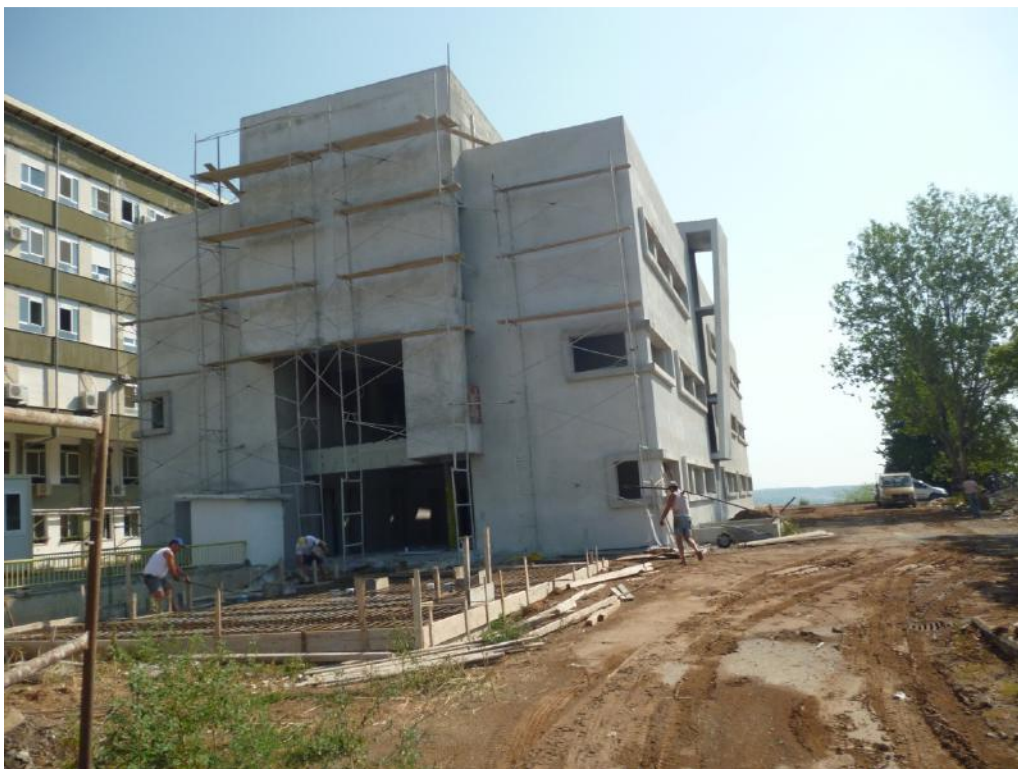
Εικόνα 4: Όψη του κτιρίου κατά την κατασκευ
