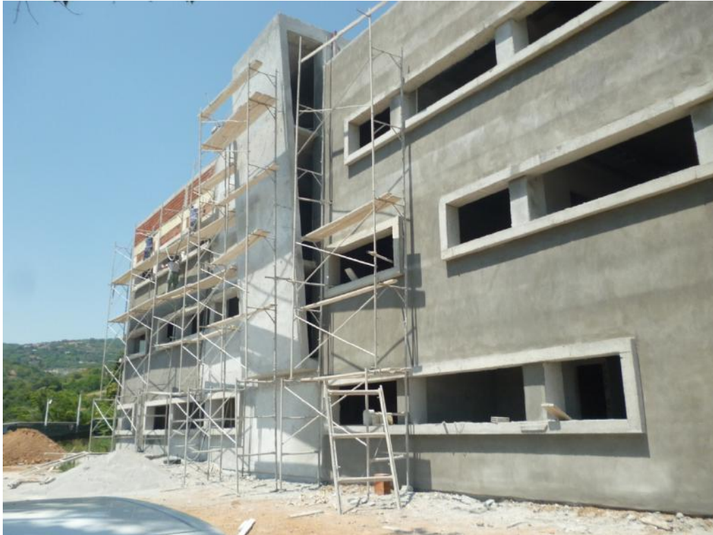
Εικόνα 3: Όψη του κτιρίου κατά την κατασκευή
