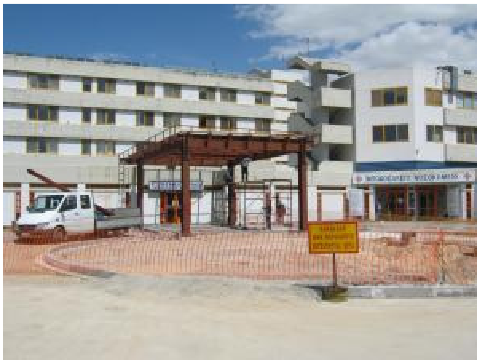
Εικόνα 1: Ο αύλειος χώρος κατά τη διάρκεια της κατασκευής
